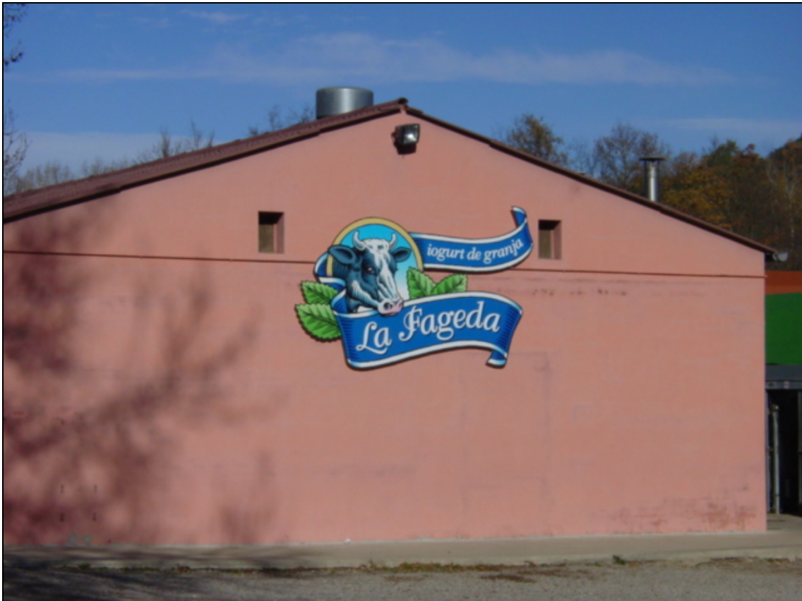
Instal·lacions per a la transformació
