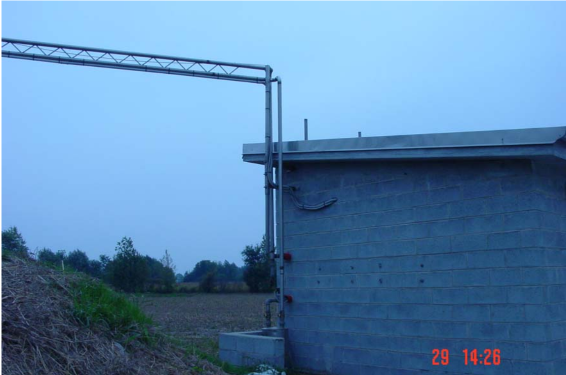
Canalització del gas
