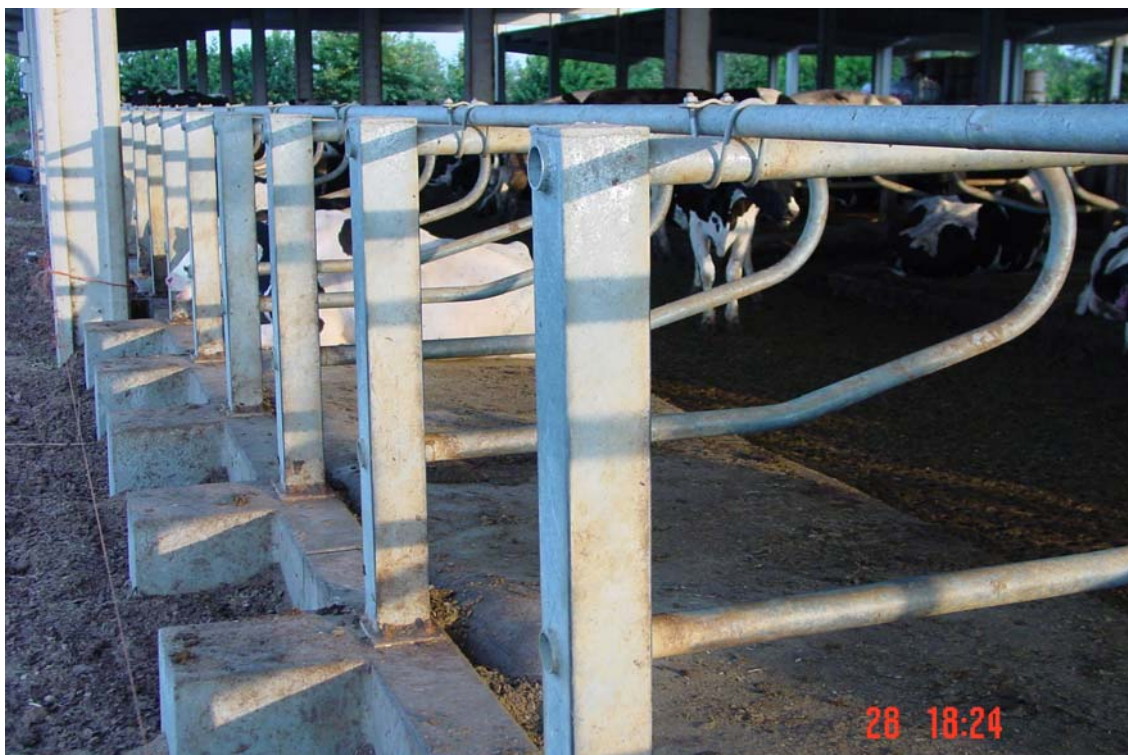
Separador col·locat massa alt des de terra
