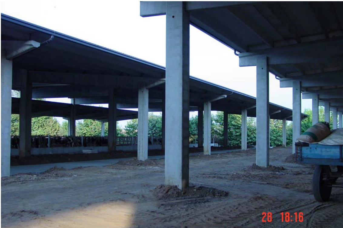
Establació lliure amb cubicles en construcció
