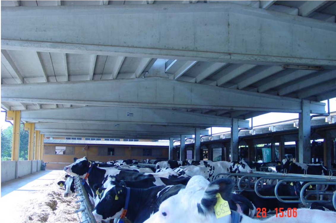
Establació amb cubicles, bigues de formigó
